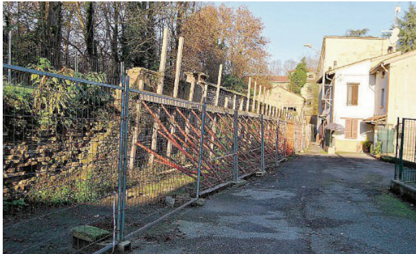
Colorno il muro settecentesco del parco della reggia, crollato nel 2013 in via Bassa Siberia.
